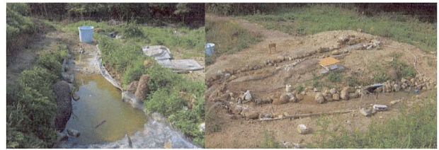
写真-7 平成18年度 ホタル水路の改造
