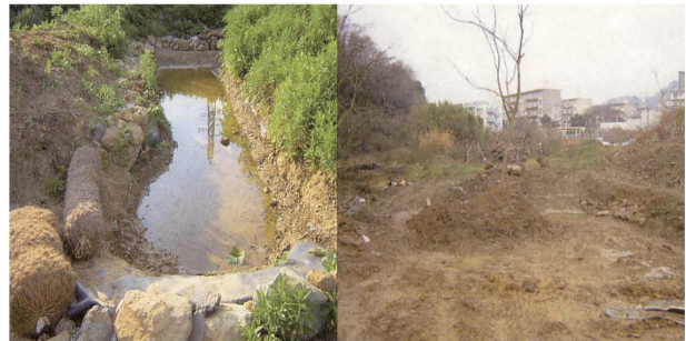
写真-2 平成16年度 小池・大池の整備
