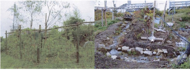
写真-12 平成19年度 ホタル水路の被覆と整備完了した水路
