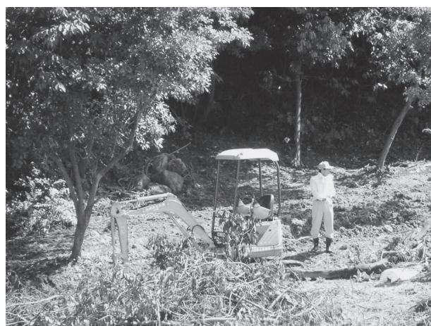
図6 小型建設機械による造成作業
